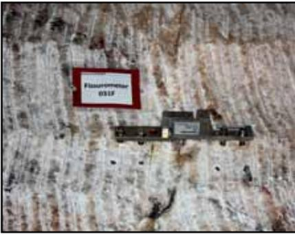
Da sich der Berg durch den damaligen Abbau bewegt, entstehen Spalten, die elektronisch überwacht werden.
