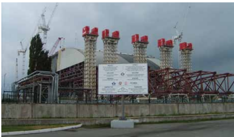
Um den Reaktor von Tschernobyl wird gegenwärtig eine zweite Schutzhülle gebaut, nachdem die erste brüchig wurde. Diese Arbeiten sind durch die mittlerweile zurückgegangenen Strahlungswerte auch ohne besondere Schutzkleidung möglich.
