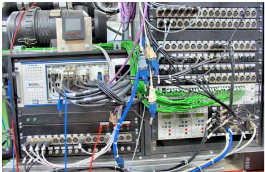
Die beim Verbrennungsvorgang von OME anfallenden Daten werden in Echtzeit verarbeitet und analysiert. Die gewonnenen Erkenntnisse fließen in noch effektiver arbeitende OME-Motoren.
