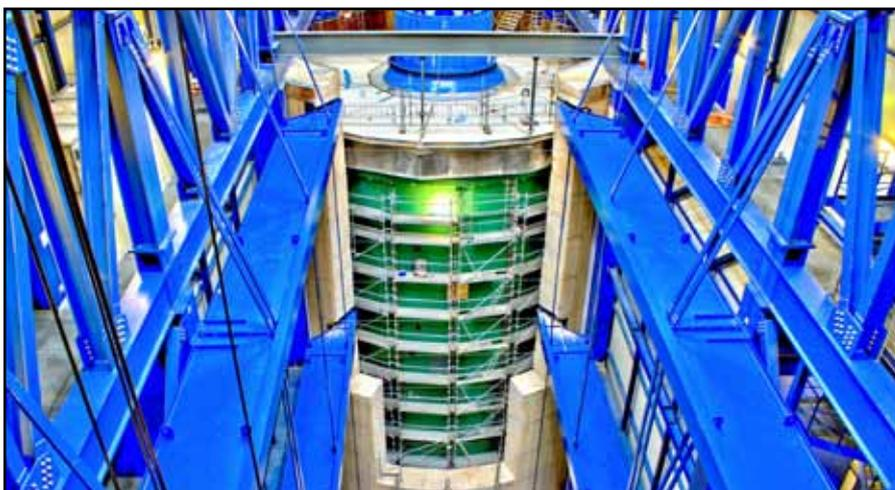
**Der 26 Meter hohe und 2100 Tonnen schwere Reaktorbehälter wurde mit einer besonderen Art Leichtbeton verfüllt, damit im Inneren verbleibende Partikel bei einem Unglück während der Demontage nicht ins Freie gelangen können.**
