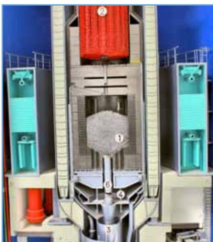
Ein Kugelhaufenreaktor besitzt einen Reaktorkern (1), der aus den Kugeln gebildet wird. Darüber befand sich beim AVR der Dampferzeuger (2), dem die Hitze aus der Kernspaltung per Heliumgas zugeführt wurde. Umgewälzte Kugeln werden über ein Abzugsrohr (6) aus dem Reaktorkern herausgeführt.
