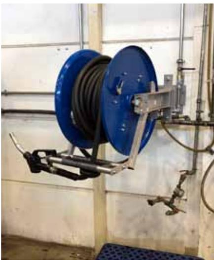
**Zentralversorgung mit Oemeta-KSS und Vor-Ort-Befüllung mittels flexibler Schlauchaufroller und Abgabepistolen bei Gehring.**
