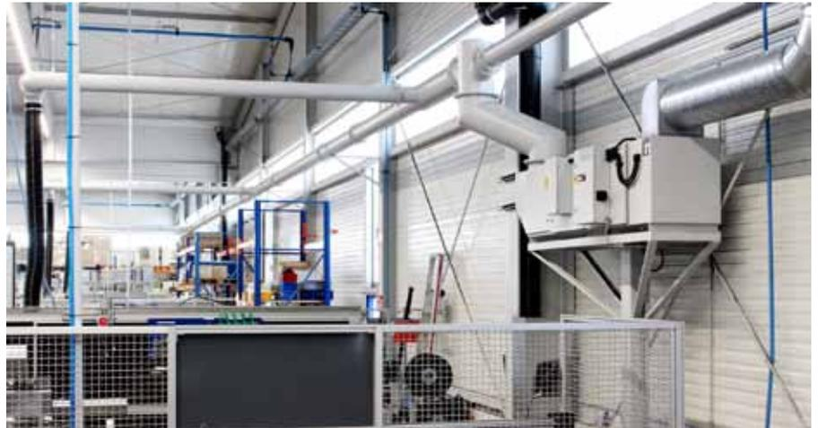
An der Sitzschienenmontage wurde eine Absauganlage mit einem Volumen von 2000m<sup>3</sup>/h installiert. Ein elektrostatischen Filter mit vorgeschaltetem Schwerkraftabscheider filtert die abgesaugte Luft. Dann wird sie nach außen abgegeben.
