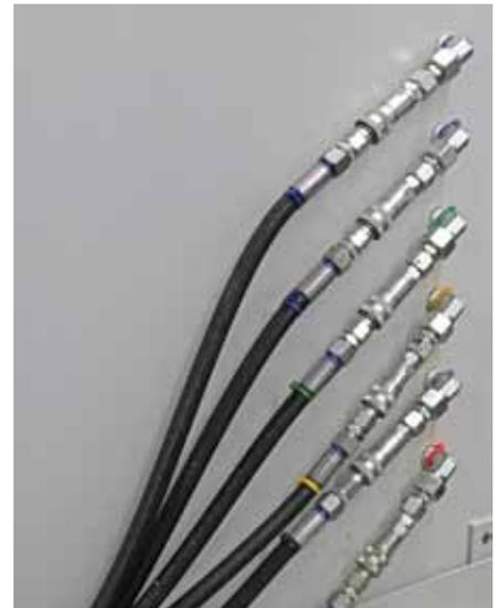
Der Anschluss des Lubicool-M-Geräts funktioniert nach dem Plug-and-Play-Prinzip über sechs Schlauchkupplungen.
