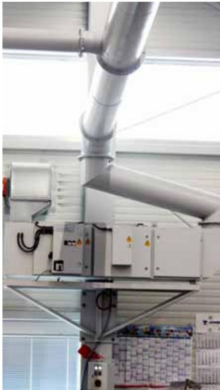
**Zweistufiger elektrostatischer Filter mit vorgeschaltetem Schwerkraftabscheider.**
