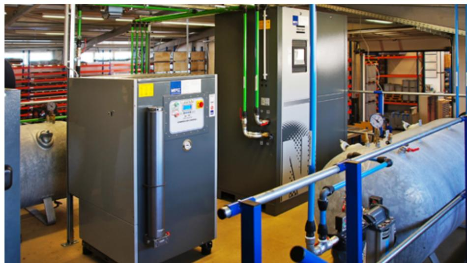
Der im N<sub>2</sub>-Generator von Atlas Copco erzeugte Stickstoff wird mit dem Booster auf bis zu 300 bar nachverdichtet und anschließend in einem Flaschenbündel zwischengespeichert.
