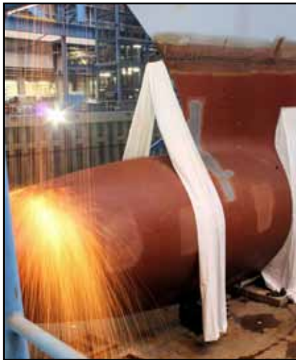
Normalfeste Schiffbaustähle bilden die Basis für alle Schiffe der Meyer Werft. Dieses Material lässt sich gut schweißen, ist robust und zudem relativ preiswert.
